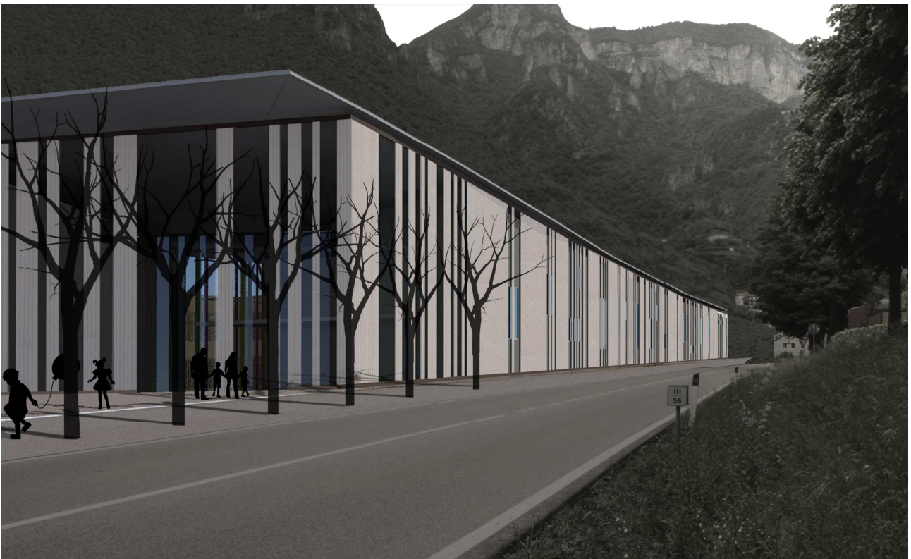
vista del fronte urbano sulla SS. Una pelle costituita da sottili lamelle di pietra riveste il corpo distributivo.
